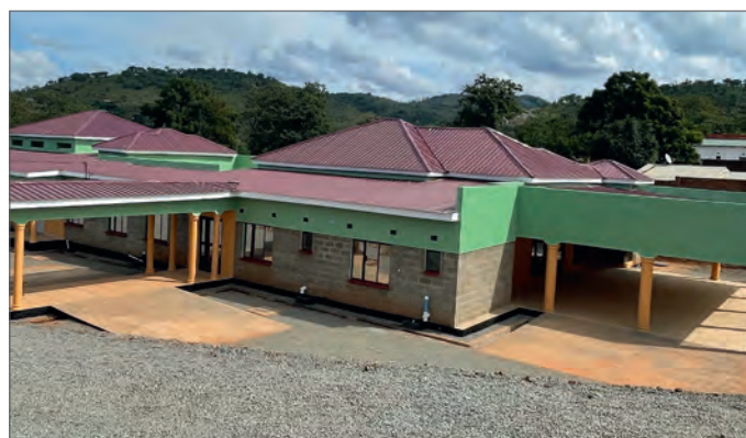
Neben den Wohnräumen für Schwestern und am Ordensleben interessierte Frauen verfügt das Haus über eine Kapelle, Aufenthaltsräume, Gästezimmer und Wirtschaftsräume.
