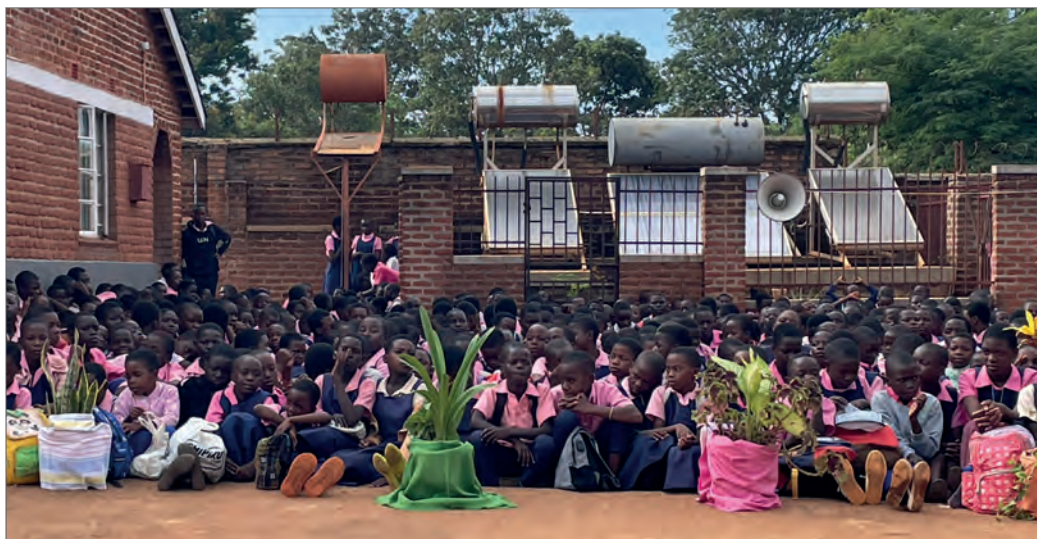
Solaranlage an der Schule der Schwestern in Madisi zur Warmwasserbereitung für die Schulküche.
